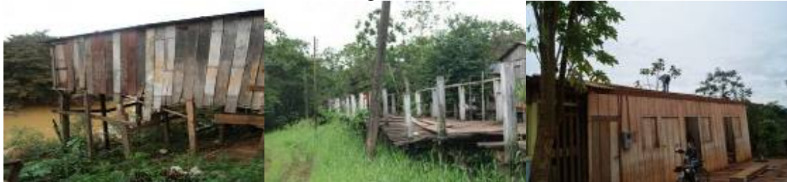
Bairro Triângulo área de risco
