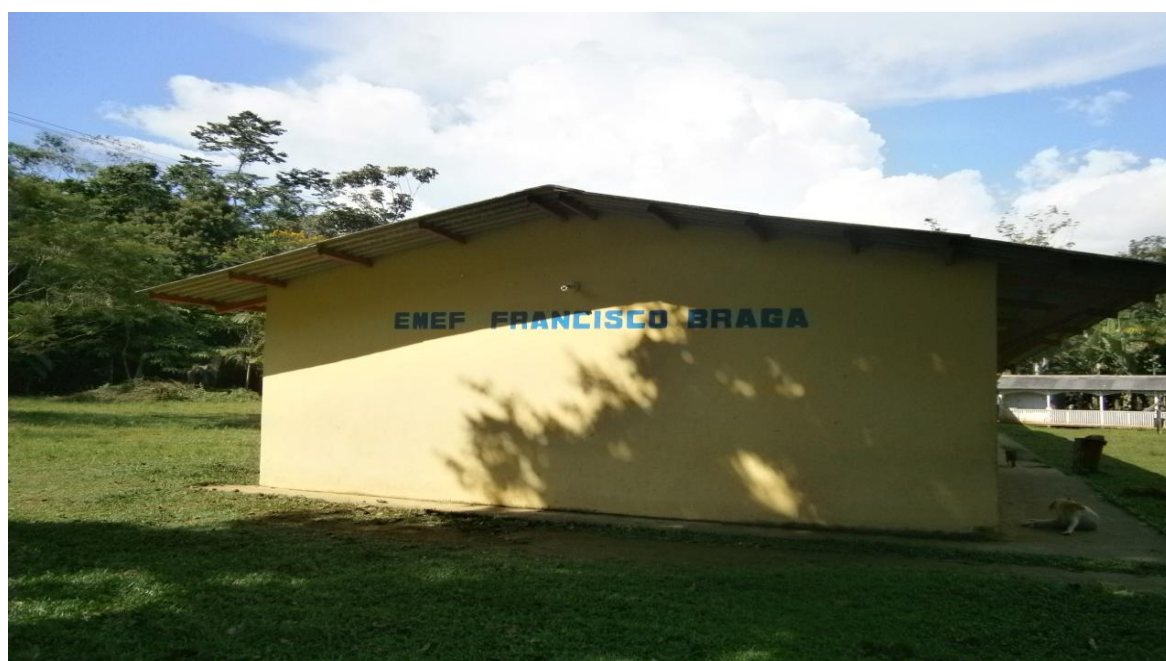
Fonte: Foto da Escola Francisco Braga – Distrito de Calama – Baixo Madeira
