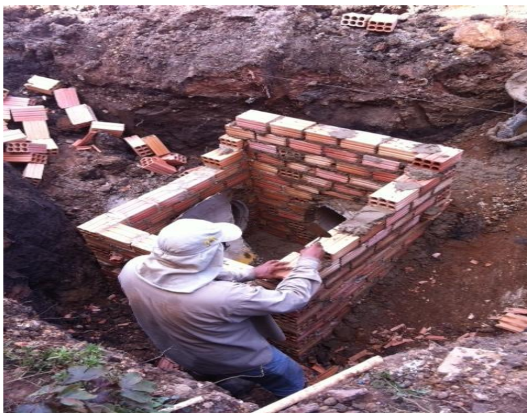
Construção e limpeza de bocas de lobo
